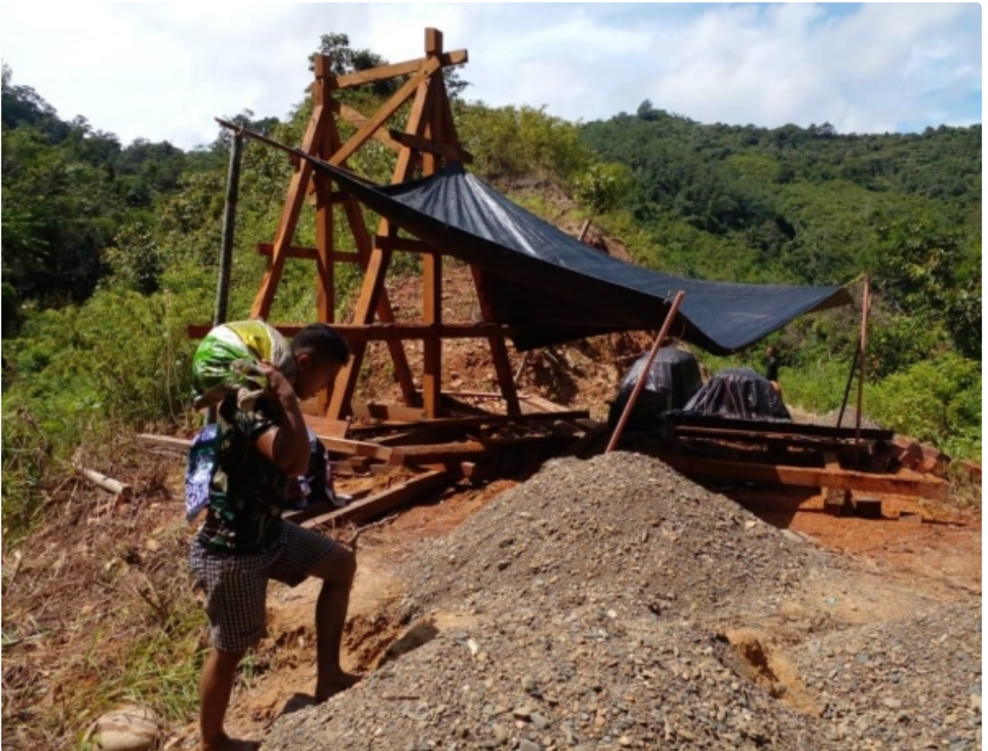
Satgas Pamtas Darat RI-MLY Yonif 621/Manuntung Karbak Buat Jembatan Penyebrangan
